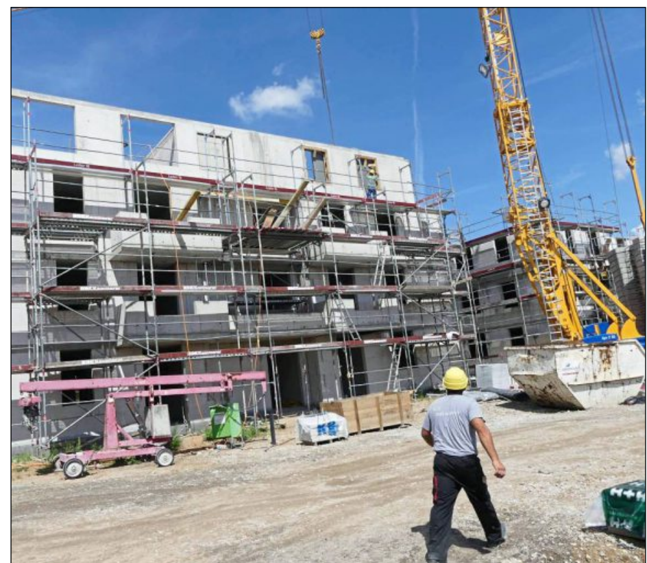
WEIT GEDIEHEN sind die Arbeiten im aktuellen Bauabschnitt des Quartiers „Luisengarten“. Ein anderer Investor baut nun nebenan in der „Sonnenallee“. Foto: Werner
