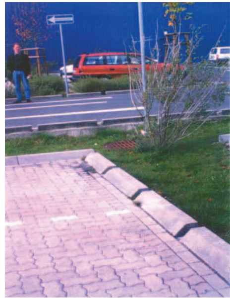
Bild 3-5: Definierte Versickerung über Rasenmulden bei wasserundurchlässiger Befestigung
