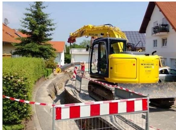
Abb. 13: Verlegung KMR-Rohr
