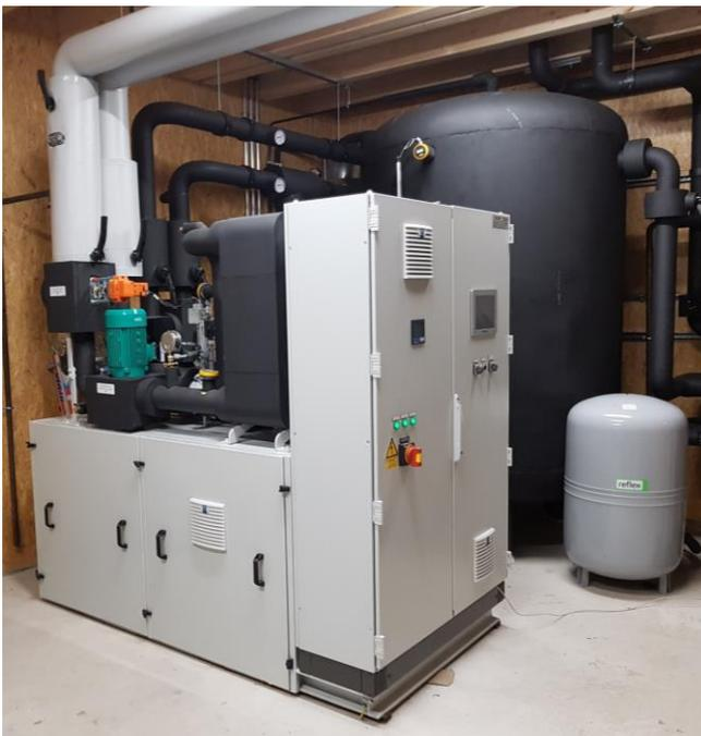
Abb. 5: Wärmepumpe mit Wärmespeicher
