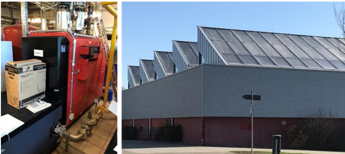
Abb. 17: Wärmeerzeuger kommunaler Wärmeverbund (Gaskessel links, Solarthermie rechts)
